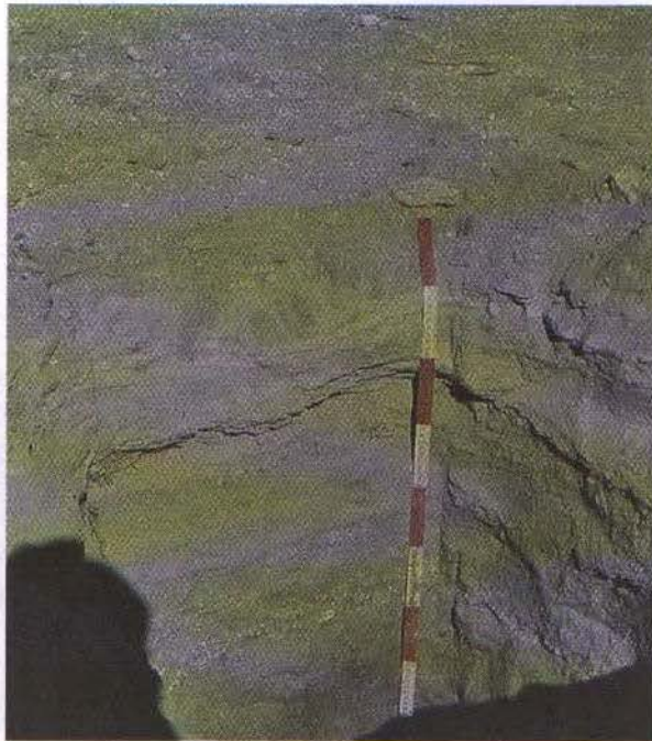
Figura 2-21. Suelo característico de las Ilanuras depositacionales , en el cual se evidencia la estratificación de los materiales. El suelo presenta un perfil A – C.
