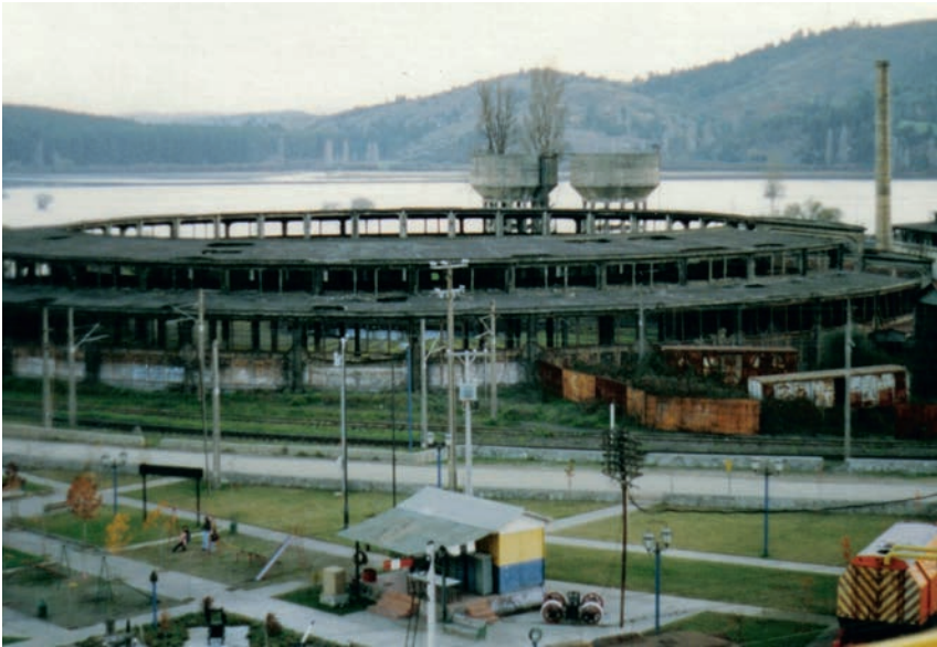
Casa de máquinas de San Rosendo, 2004. Esta infraestructura fue fundamental durante el auge ferroviario que vivió la localidad a inicios del siglo XX (gentileza de Carolina Tapia V).
