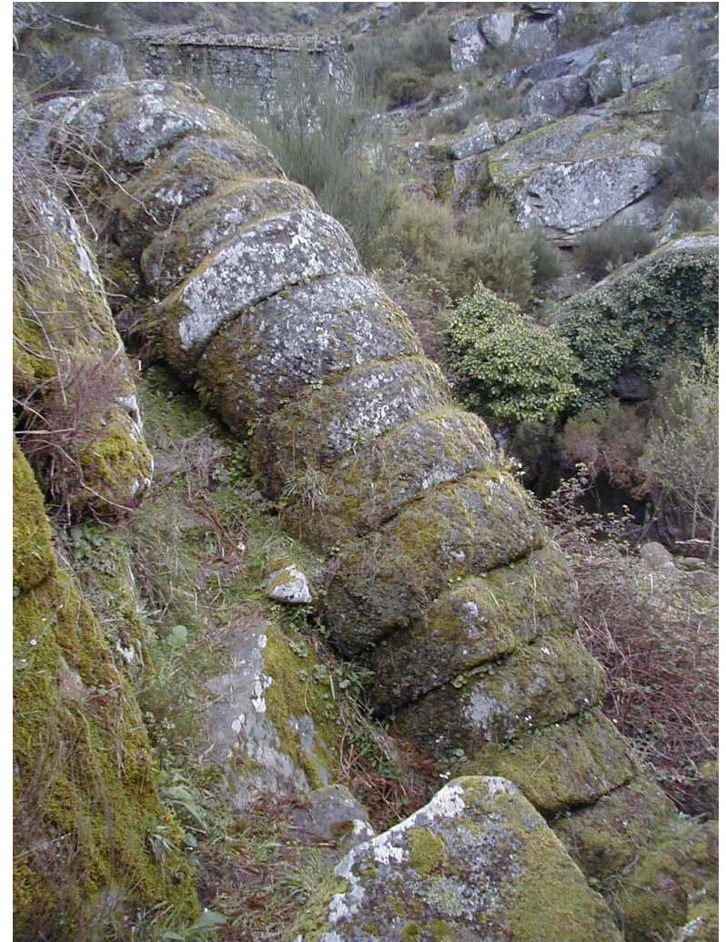
Cubo formado por anillos de granito. Molino n.7
