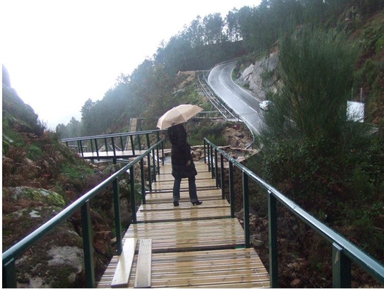
Plataforma de acceso al molino n. 03
