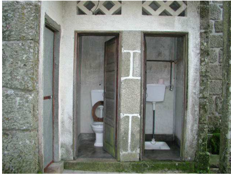
Foto Superior: Sanitarios de la antigua escuela
