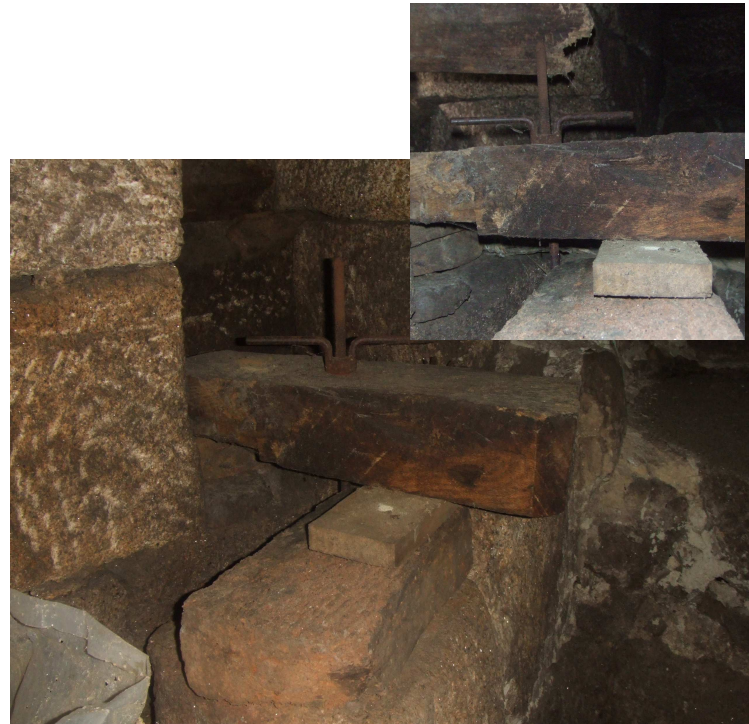
Fotos superiores: Detalle de Aliviadouro y pieza para regularlo del molino n.º 3
