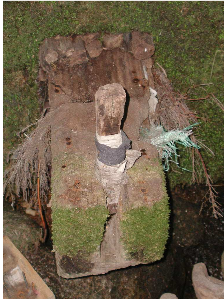
Detalle de bucheiro y cunha para regular la salida del agua. Molino n.º 3
