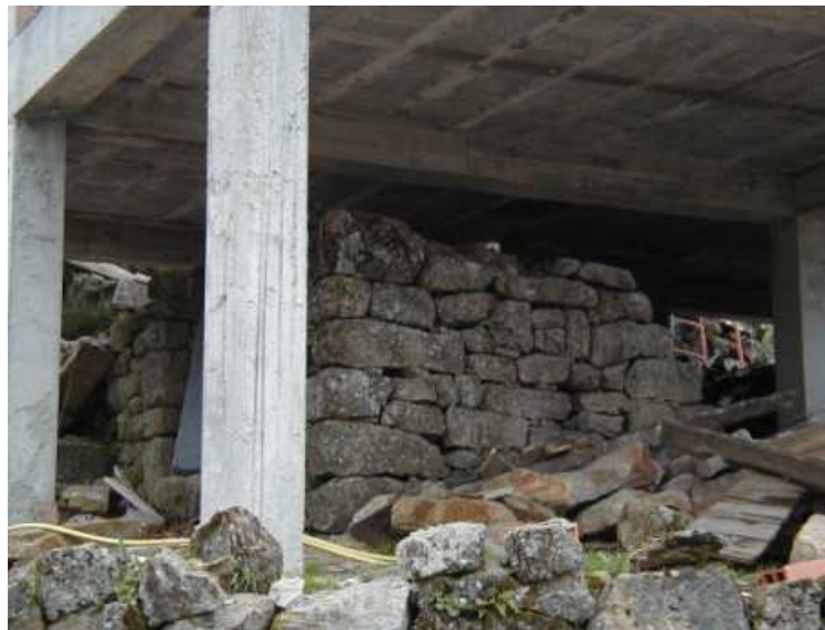
Casa construida sobre la edificación antigua 59
