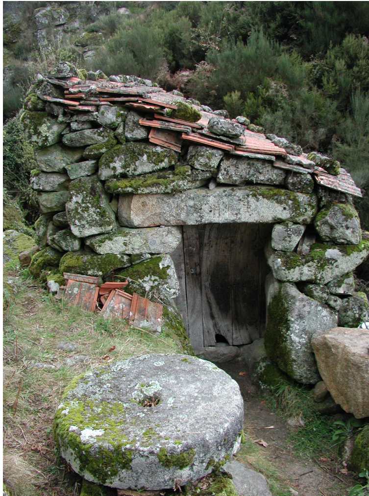
Foto Superior: Fachada principal y puerta de acceso del Molino n.º 7
