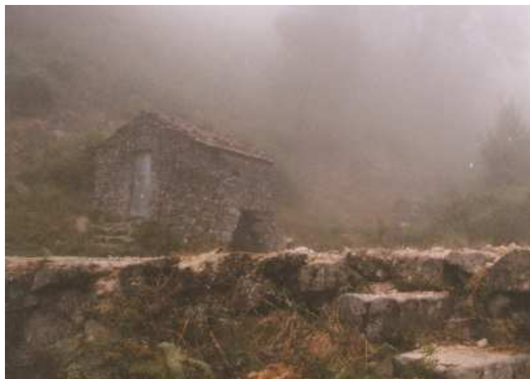
Foto superior: en primer plano, escaleras de acceso a molino n.º 5; en segundo plano, molino n.º 4.
