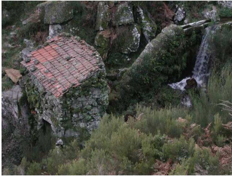
Vista general de Molino N.º 7
