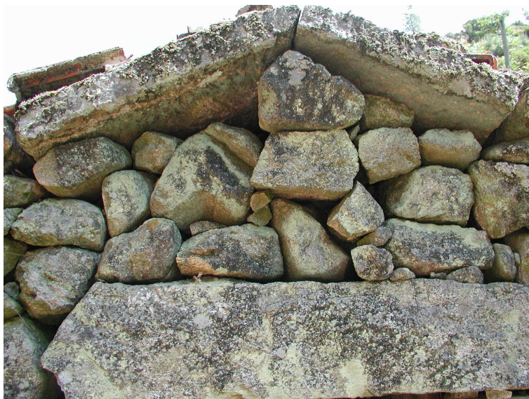
Detalle de la fachada principal del molino n.º 2
