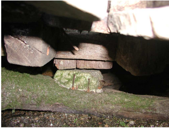
Detalle del árvore asentado sobre el urriero , Molino n.º 2
