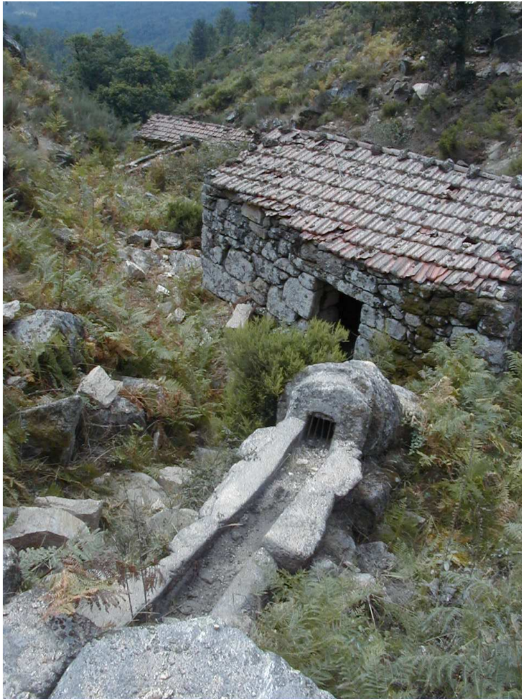
Levada, grade e anillos del cubo. Molino n.º 5
