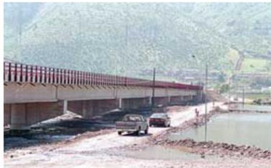
En la foto, casi terminado, el ex puente San José de Cabildo, de 500 metros de largo, que pasó a llamarse "Alfredo Cerda Jaraquemada", destacada figura pública de la provincia de Petorca y de la región.
