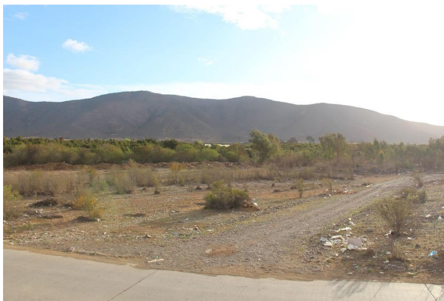
Fotografía 29. Badén Valle hermoso, vista desde el puente peatonal hacia la costa, septiembre del 2019. Registro propio.
