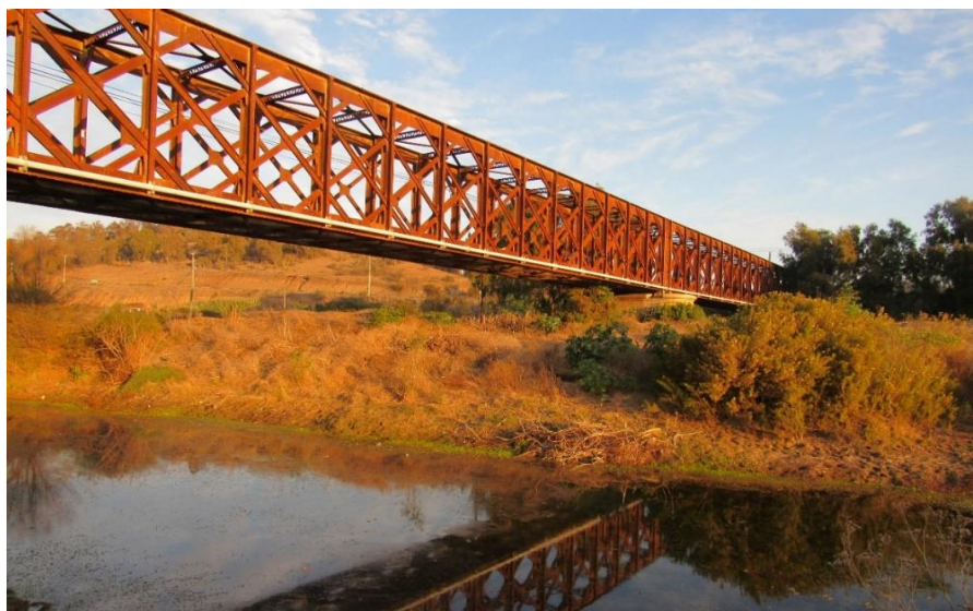
Fotografía 33. Puente Ferroviario Quinquimo, vista desde el norte. Pullally, junio del 2019. Registro propio.
