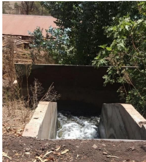
Fotografía 13. Canalización del río, enero 2020. Registro propio.
