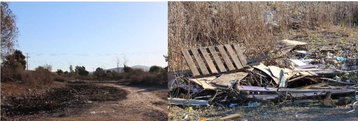
Fotografía 31. Cauce del río en Placilla, vista Fotografía 30. Microbasural en el lecho del río. hacia la costa. Septiembre del 2019. Registro Septiembre del 2019. Registro propio.
