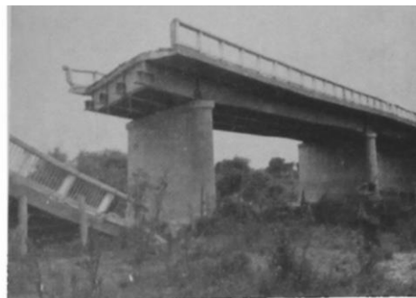
Puente sobre el estero Pullalli, carretera Panamericana. Extremo norte del mismo
