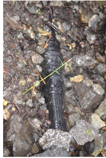
Imagen n°36: Manguera de captación de agua, dentro del PNLC
