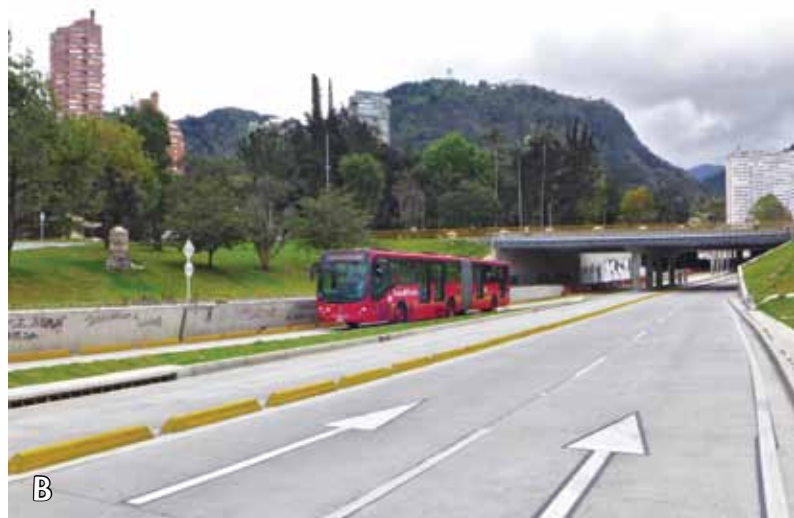
Figura 7.2. A. Un articulado del sistema TransMilenio en el sector del Eje Ambiental en Bogotá. B. Panorámica de la calle 26 de Bogotá durante el día sin carro del 2013.
