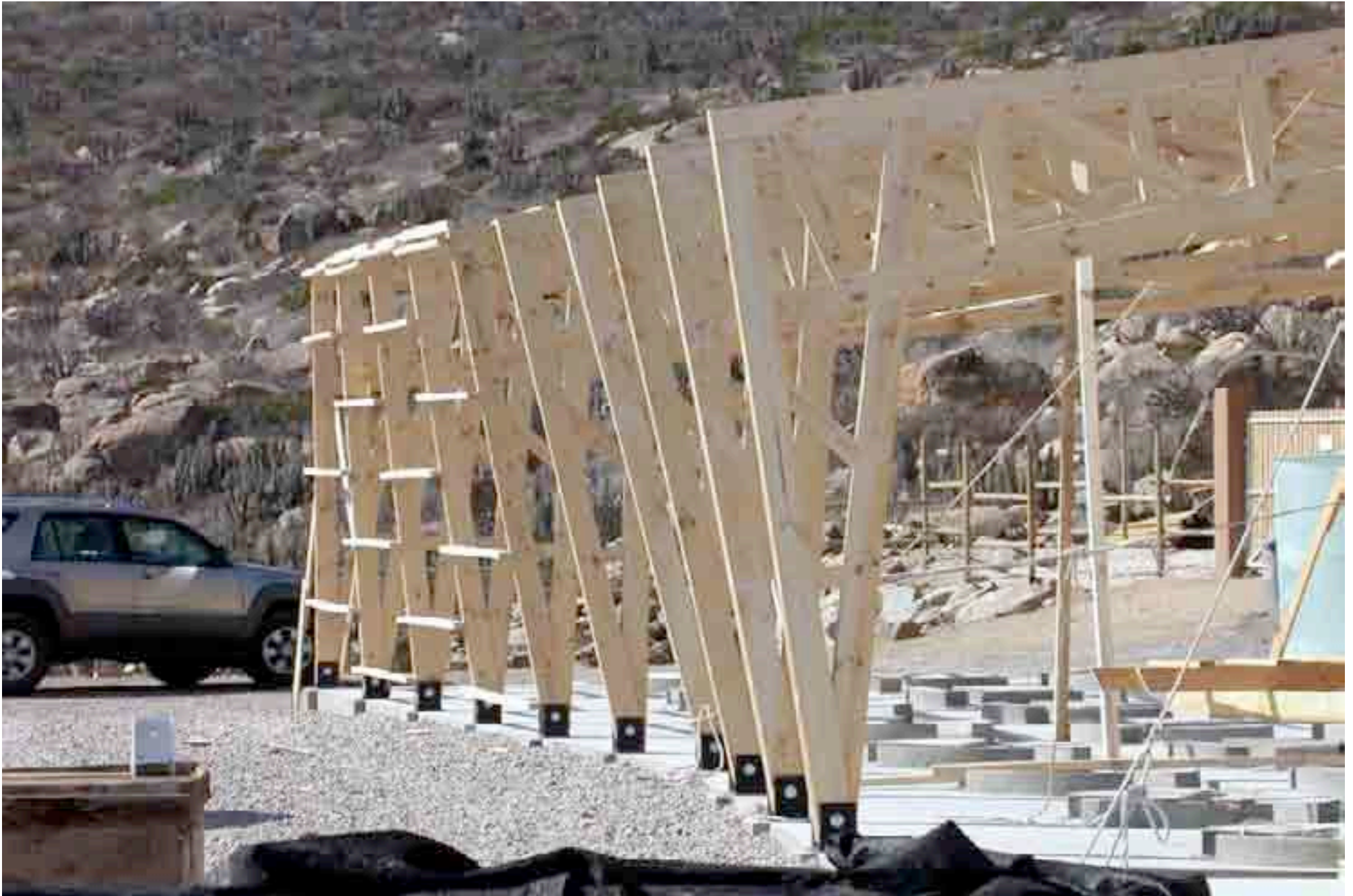
Galpones Panur, IV Region, WAR Arquitectos
