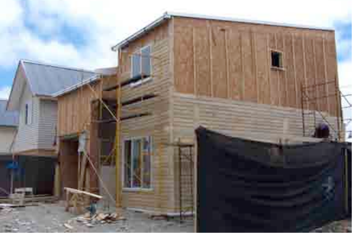
REVESTIMIENTO EXTERIOR / SEPARADORES CAMARA VENTILADA
