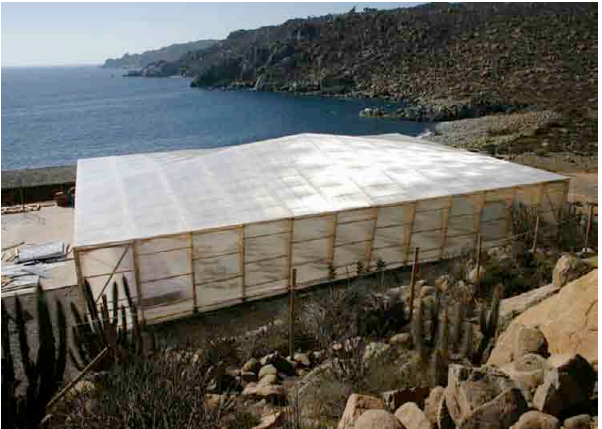
Galpones Panur, IV Region, WAR Arquitectos
