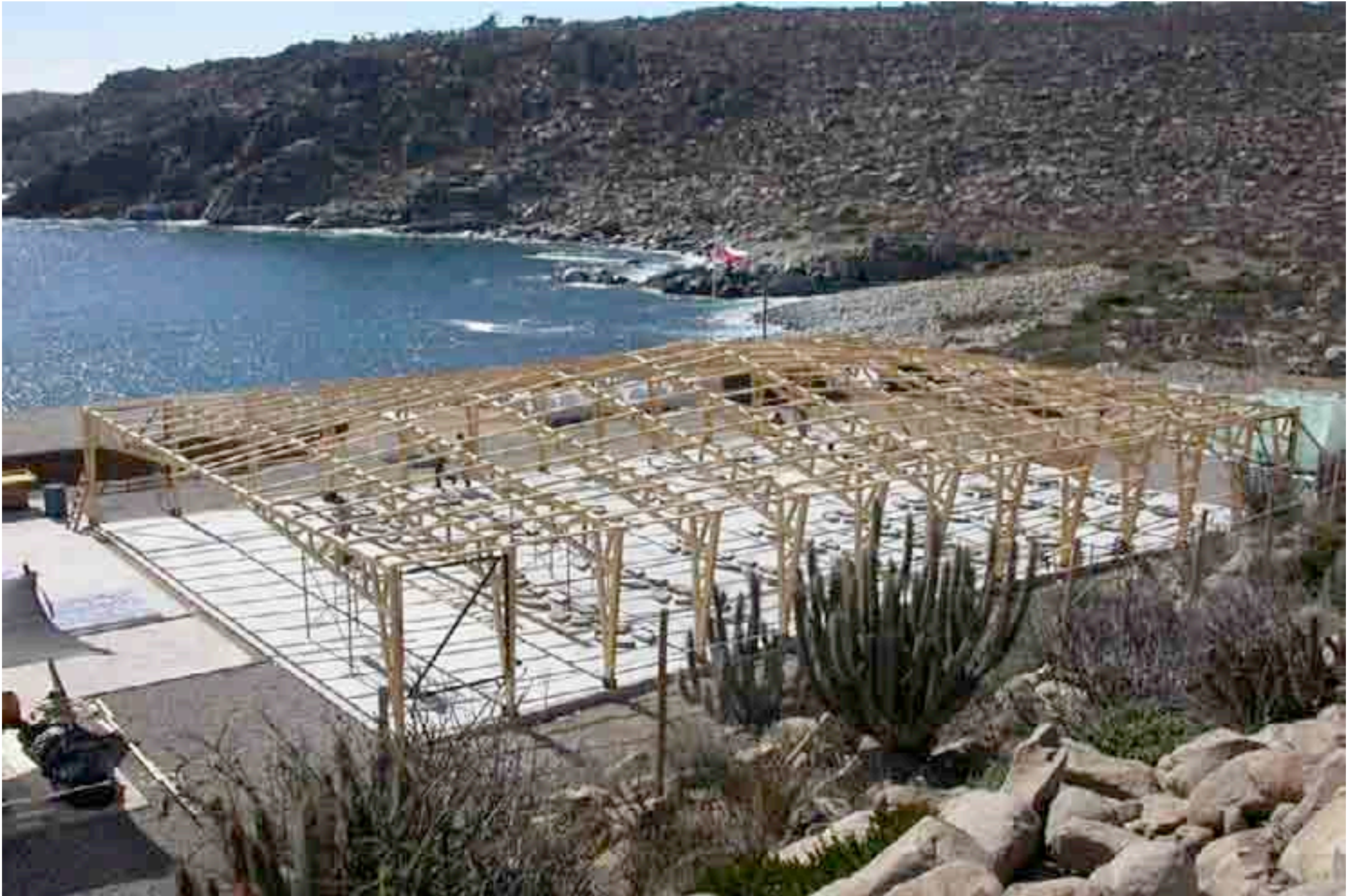
Galpones Panur, IV Region, WAR Arquitectos
