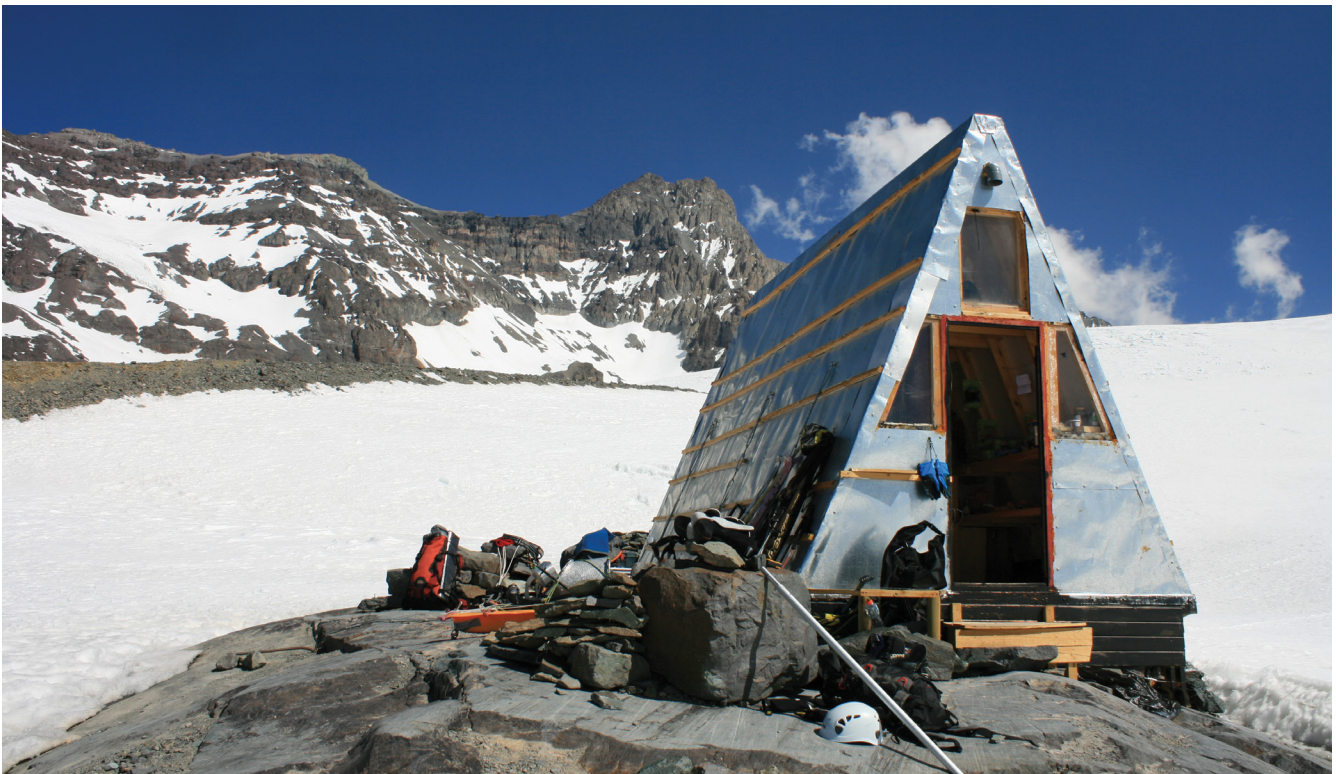
Figura 58. REFUGIO DE ALTA MONTAÑA TIPO A. GLACIAR OLIVARES ALFA, CHILE. Fuente: Sebastián Cisternas.
