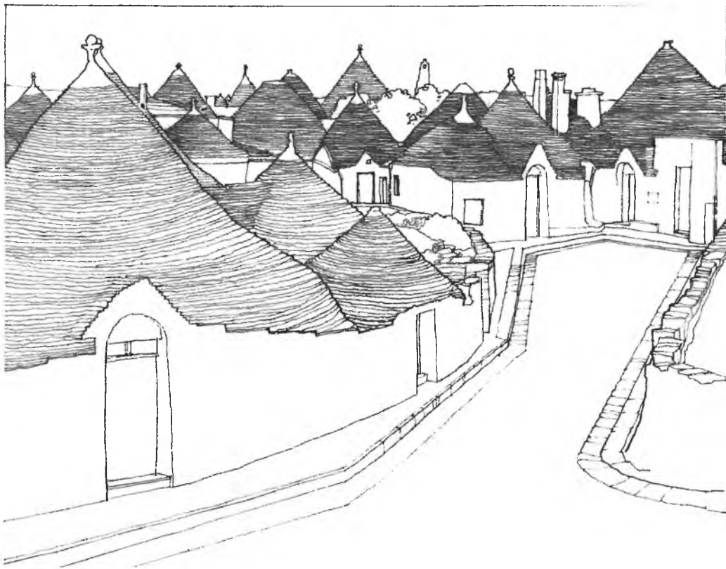
Pueblo trulli , Alberobello, Italia. Viviendas tradicionales de mamposteo a hueso que datan del siglo XVII.
