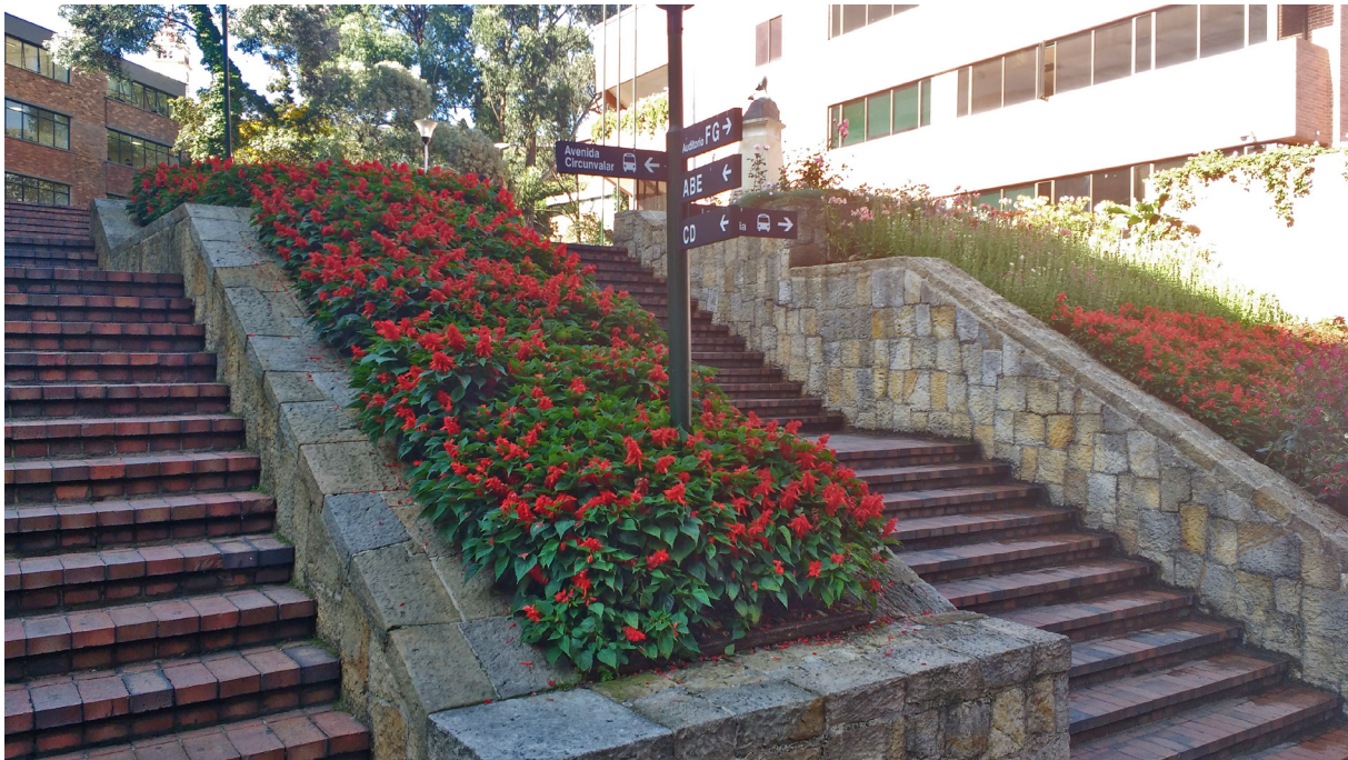
Figura 2. Infraestructura de arquitectura verde, Universidad Externado de Colombia, Bogotá, DC Fuente: archivo personal de los autores
