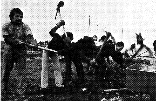
Fig. 1.—Se empieza abriendo zanjas. Luego habrá que aprender a hormigonar, preparar armaduras, prefabricar elementos y pintar. A veces se llega hasta a hacer la carpintería y herrería de obra.
