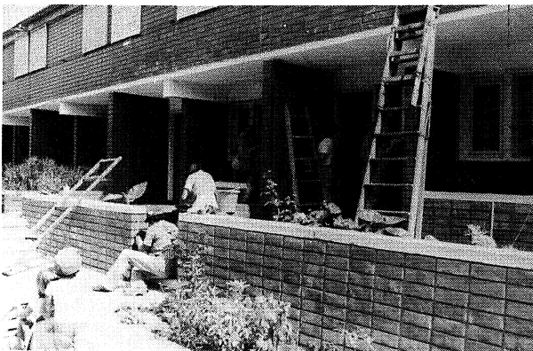
Fig. 4.—Terminada la obra, el esfuerzo se vuelca al mantenimiento, así como al mejoramiento de las viviendas y el entorno.
