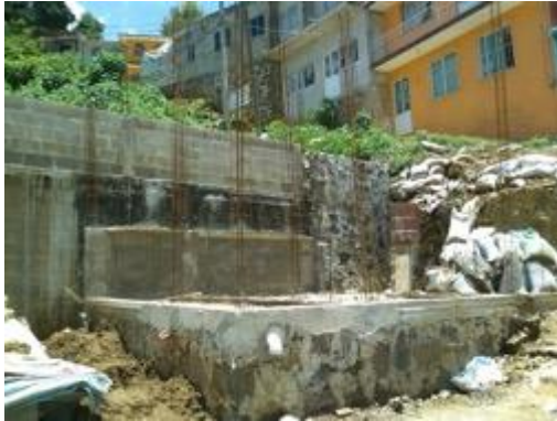
Fotografía 26.- Cárdenas, V. Trabajos de construcción de cimentación para vivienda popular. 2010
