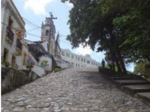
Fotografia 40.-Vista da ladeira da misericórdia em Olinda. Fonte: O Autor
