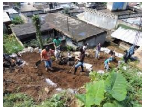
Fotografía 24.-Cárdenas, V. Trabajos de despalme de predio para vivienda en Xalapa, Veracruz, México. 2010
