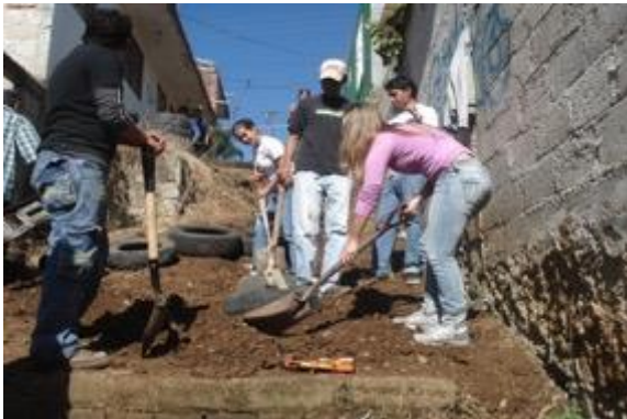
Fotografía 22.- Cárdenas, V. Trabajos de despalme de terreno en Andador Apalaches colonia Casa Blanca. Xalapa, Veracruz, México. 2008.
