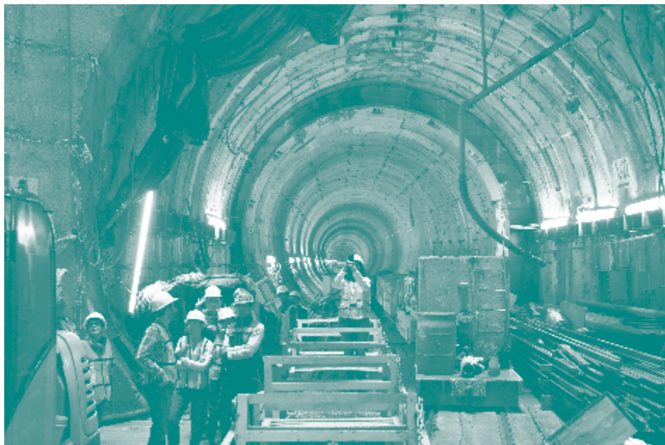
Figura 5. Túnel emisor oriente
