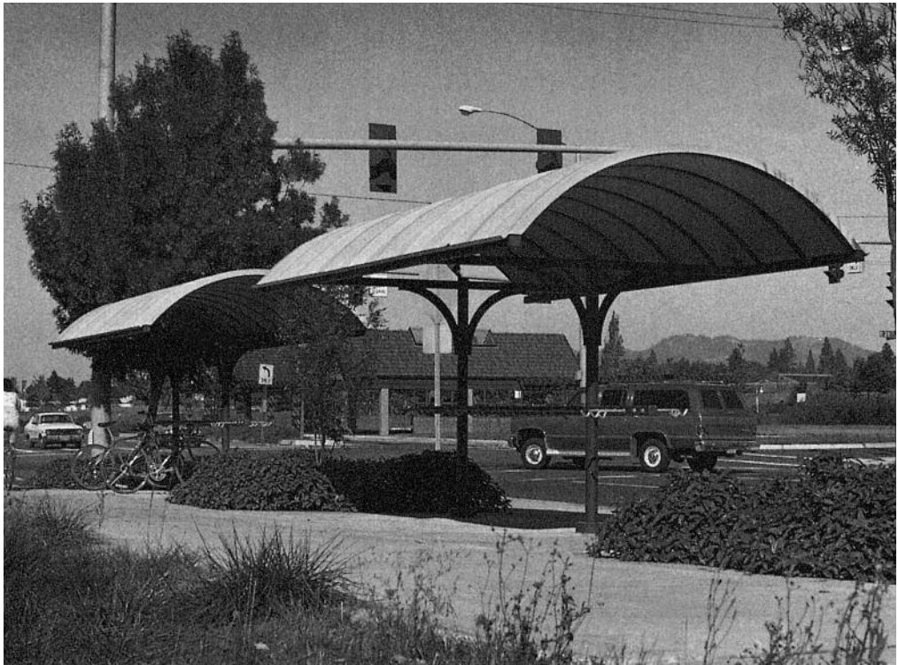
3. Cobertizo para guardar bicicletas, Departamento de Tráfico, Eugene (Oregón), 1984. El cobertizo para bicicletas forma parte de un conjunto de edificios, incluyendo una zona de terminal de autobuses, destinado a fomentar el uso del transporte público.
