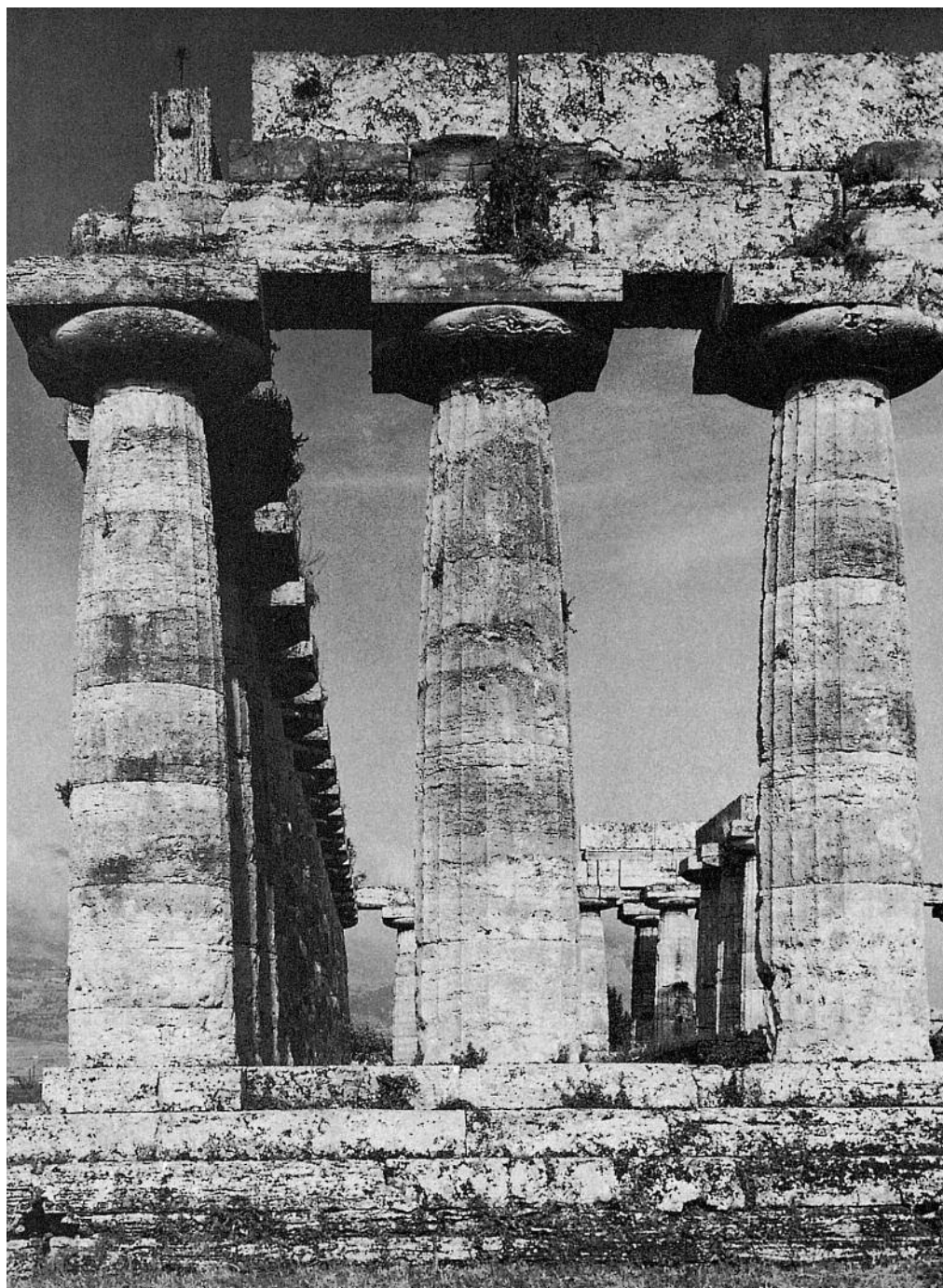
2.1. Columnas, templo de Poseidón, Paestum (Italia), ca. 550 a. de C. Esta columna de piedra, de mayor tamaño de lo estructuralmente necesario, transmite una inequívoca impresión de su resistencia.
