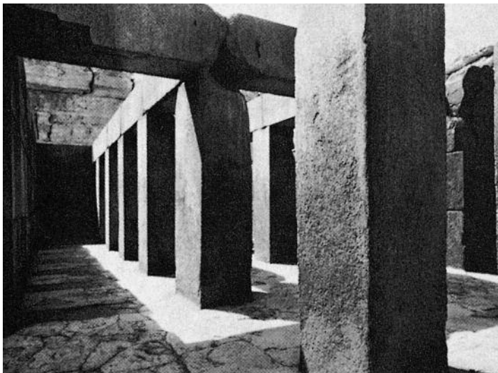
2.7. Templo del Valle, pirámide de Kefrén, Gizeh (Egipto), ca. 2570-2500 a. de C. Este templo constituye una de las expresiones más puras del sistema estructural de columna y dintel.
