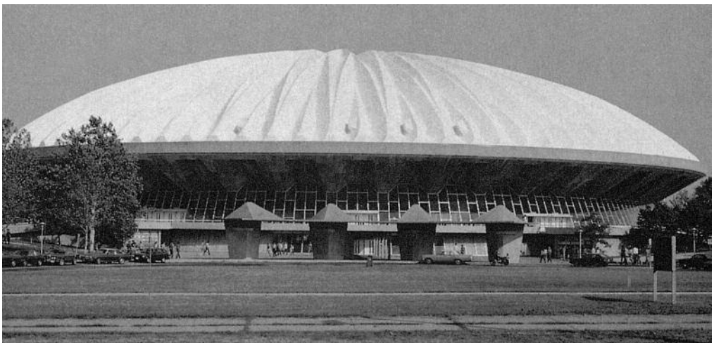
2.30. Harrison & Abramovitz en colaboración con los ingenieros Ammann & Whitney, salón de actos de la Universidad de Illinois, Champaign, 1961-1962. Esta cúpula en forma de lámina plegada tiene unas ondulaciones que irradian desde el centro.
