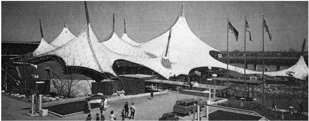
2.35. Frei Otto, pabellón de Alemania, Exposición Universal de Montreal de 1967, Montreal (Quebec, Canadá). En esta construcción, la envoltura protectora es una membrana soportada por unos mástiles que mantienen en tensión a una retícula de cables entrelazados, los cuales están amarrados a una serie de puntos de anclaje al terreno.
