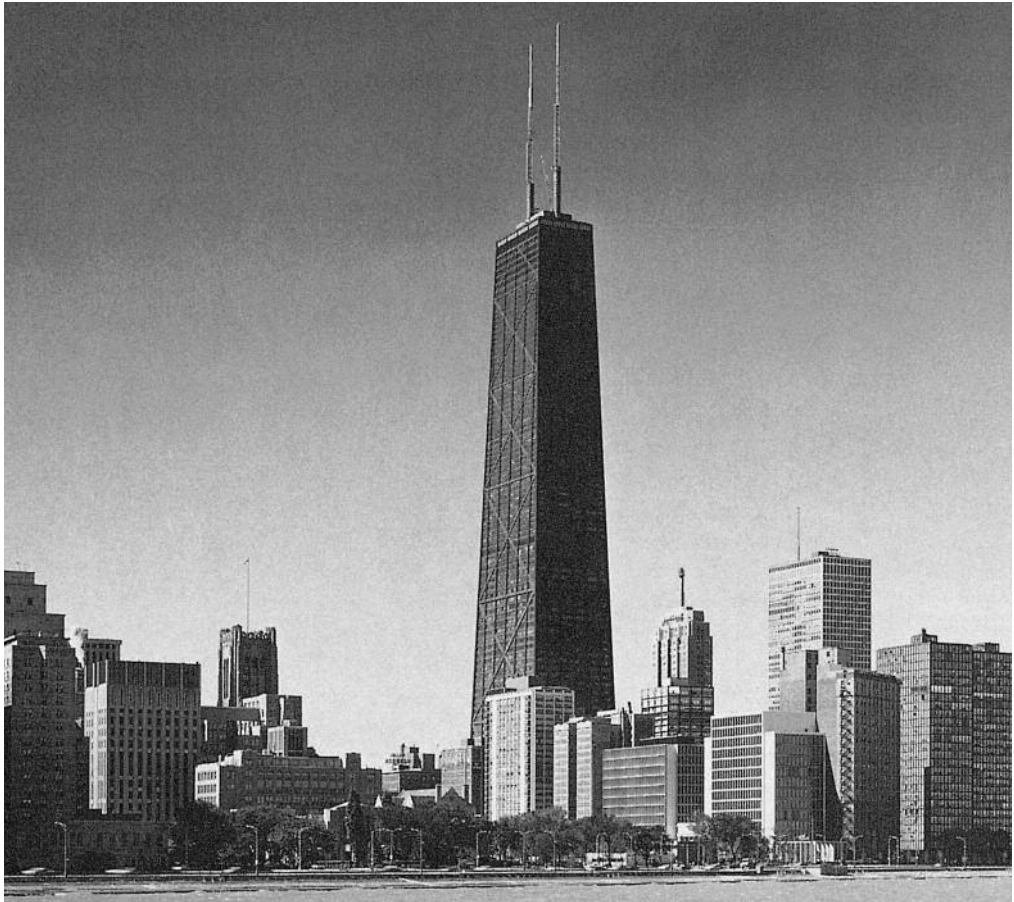
7.14. Skidmore, Owings & Merrill, John Hancock Center, Chicago, 1965-1970. En los edificios de gran altura, la presión lateral del viento se convierte en un factor de diseño estructural más significativo que las cargas gravitatorias; de ahí que, como en el caso del Hancock Center, sea necesario rigidizar los pilares exteriores mediante riostras diagonales.
