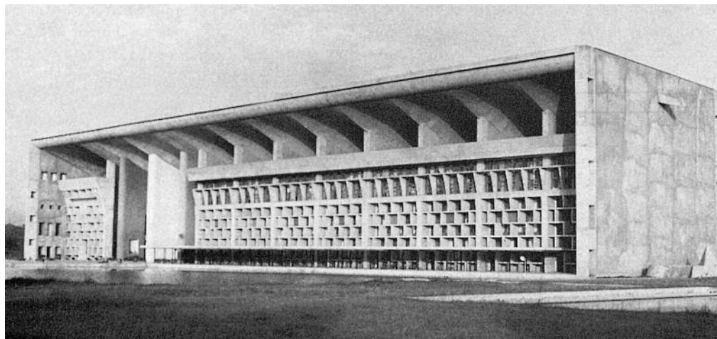
7.9. Le Corbusier, edificio del Tribunal Supremo, Chandigarh (Punjab, India), 1951-1956. En este clima semitropical, Le Corbusier empleó el parasol indio tradicional para preservar al edificio de los rayos solares directos. La gigantesca doble cubierta ondulada está sostenida en volandas sobre grandes pilares, para que la brisa circule libremente entre ella y el edificio, enfriando su cara inferior.
