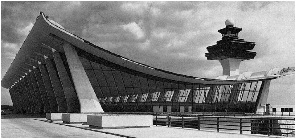
2.32. Eero Saarinen, terminal del aeropuerto internacional Foster Dulles, Washington DC. 1958-1962. La cubierta está colgada de cables anclados en las vigas de borde que corren a lo largo de los lados del edificio.
