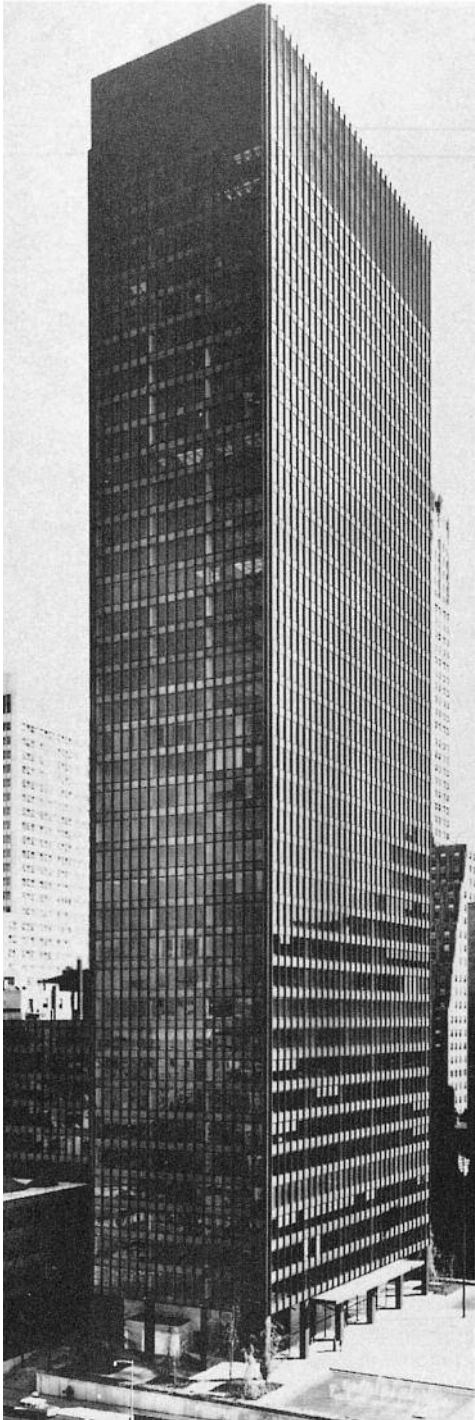
7.11. Ludwig Mies van der Rohe en colaboración con Philip Johnson, edificio Seagram, Nueva York, 1954-1958. Este edificio está totalmente sellado y la regulación de su temperatura interna se ha confiado a unos extensivos sistemas de calefacción y aire acondicionado.
