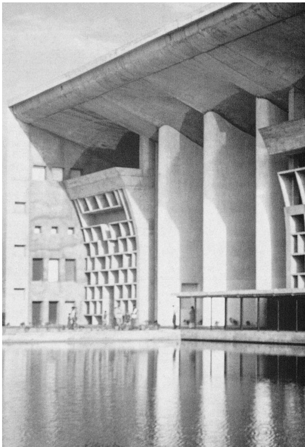
7.10. Le Corbusier, edificio del Tribunal Supremo, Chandigarh (Punjab, India), 1951-1956. Detalle de la fachada. Los profundos huecos de las ventanas y el parasol adicional de la cubierta interceptan el intenso calor del sol subtropical hacia el interior de las dependencias –una sencilla solución, no técnica, para resolver un acuciante problema–.
