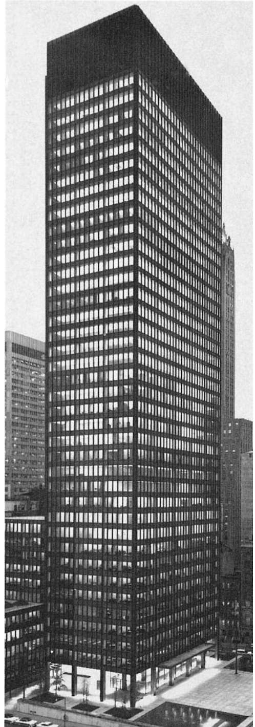
7.12. Edificio Seagram, Nueva York. Esta vista nocturna revela hasta qué punto el edificio es transparente a la energía radiante. Durante el día, la luz solar penetra y atraviesa el edificio con la misma facilidad con que la luz artificial se escapa durante la noche.
