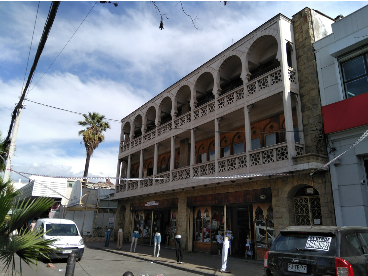
Local comercial en calle Santa Filomena, comuna de Recoleta, 03-12-18.
