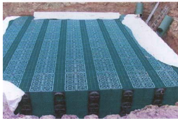
Bloque de filtración e instalación del sistema Rigo-Fill
