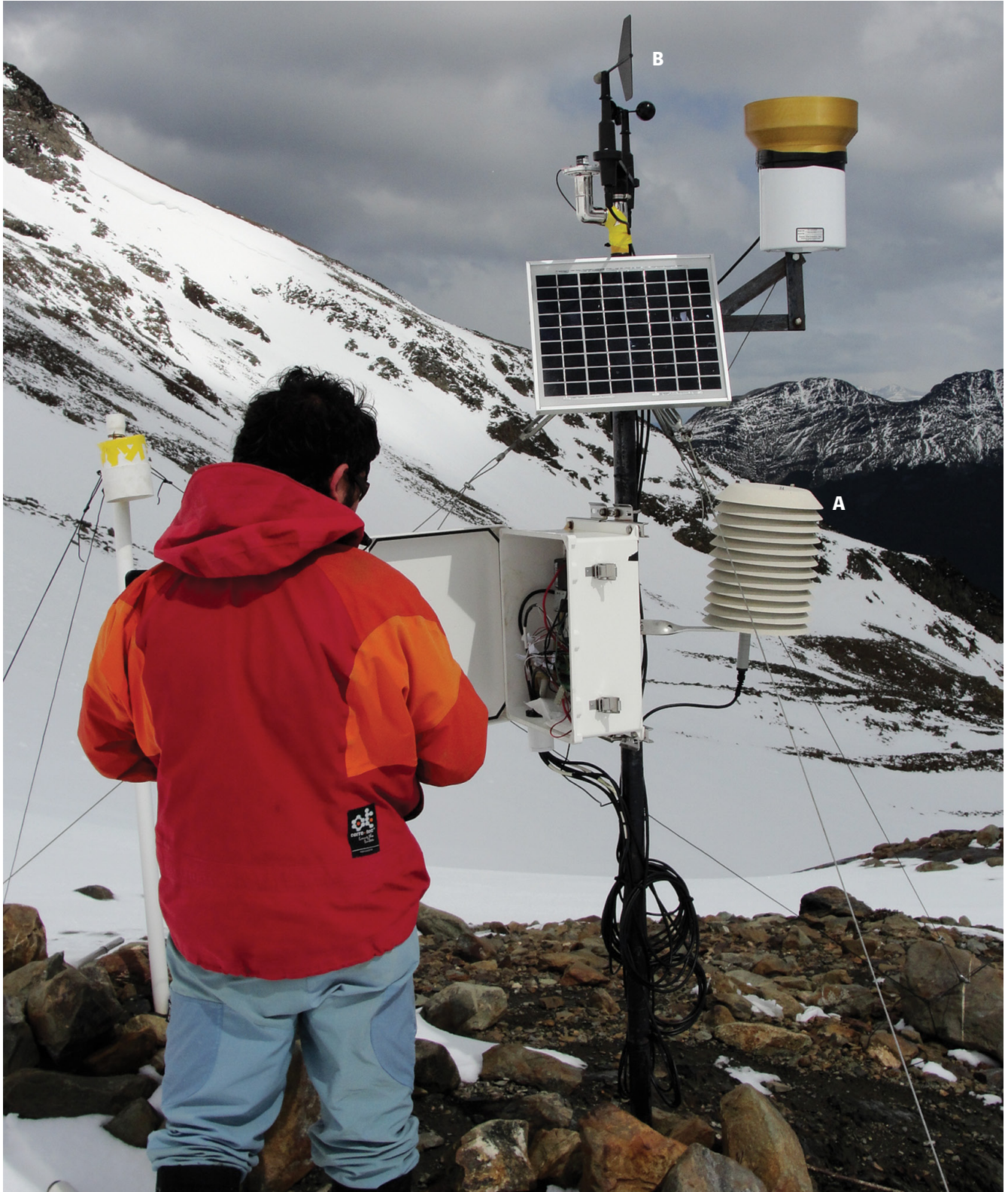
Figura 83. ESTACIÓN METEOROLÓGICA AUTOMÁTICA (AWS). A) SENSOR DE TEMPERATURA Y HUMEDAD RELATIVA Y B) ANEMÓMETRO. GLACIAR VINCIGUERRA. Fuente: Rodolfo Iturraspe.
