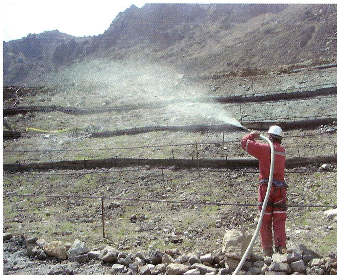
Aplicación de hidrosiembra en ladera de Cancha Kelly
