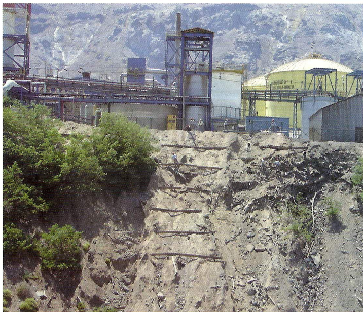
Instalación de barrera de lampazo en ladera de quebrada Tes
