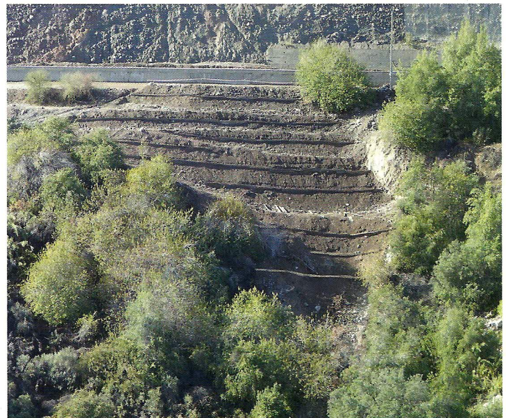
Sistemas de barrera de lampazo en ladera reconstruida de Socavón La Paula
