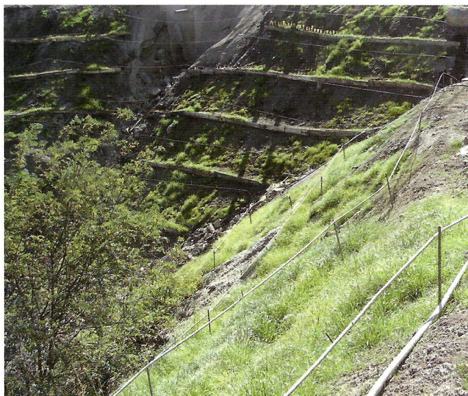
Ladera de quebrada Tes luego de la aplicación de compost y cal.
