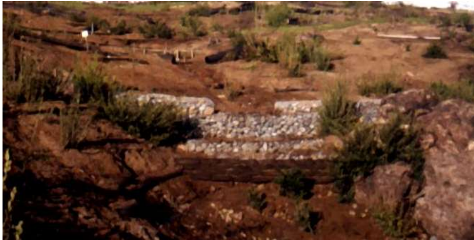
Diques de Gaviones proyecto Restauración Sierras de Bellavista (Lemus, 2001)
