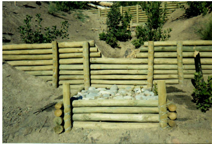
Diques de madera proyecto Restauración Sierras de Bellavista (Lemus, 2001)
