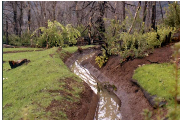
Canal de desviación proyecto Restauración Sierras de Bellavista
