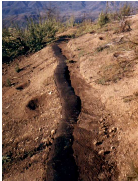
Sacos rellenos de tierra complementarios con Terraza forestal, proyecto Restauración Sierras de Bellavista (Lemus, 2001)
