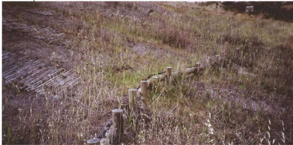
Empalizada de Postes de madera proyecto CONAF/JICA, 1998
