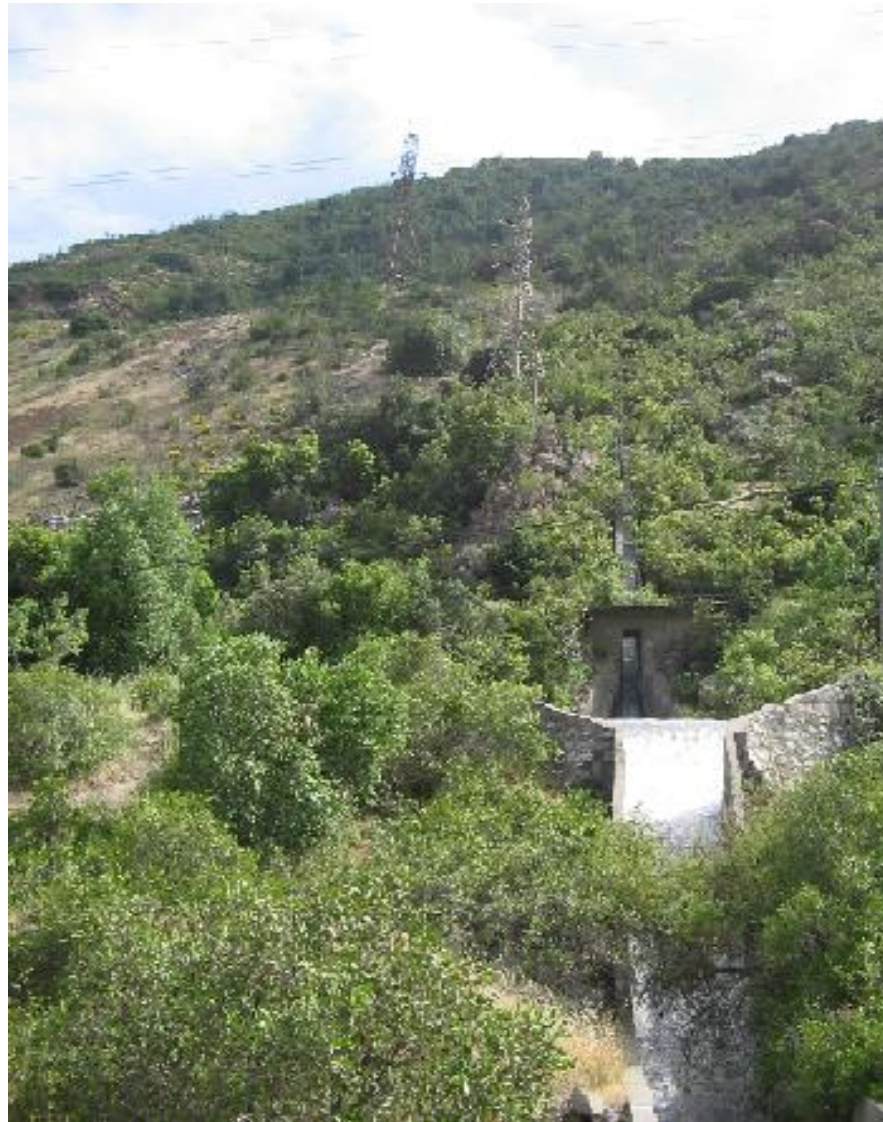
DESCARGA DESDE CANAL SAUZAL
