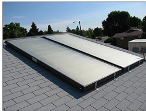
Figura 2.5: Conjunto de colectores solares planos en el techo de una vivienda
