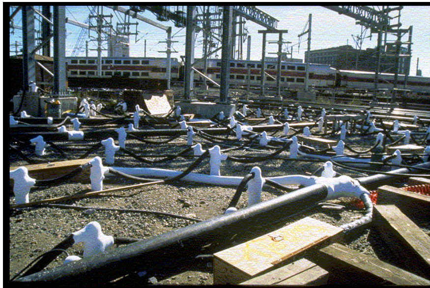
Túnel bajo la línea del tren
