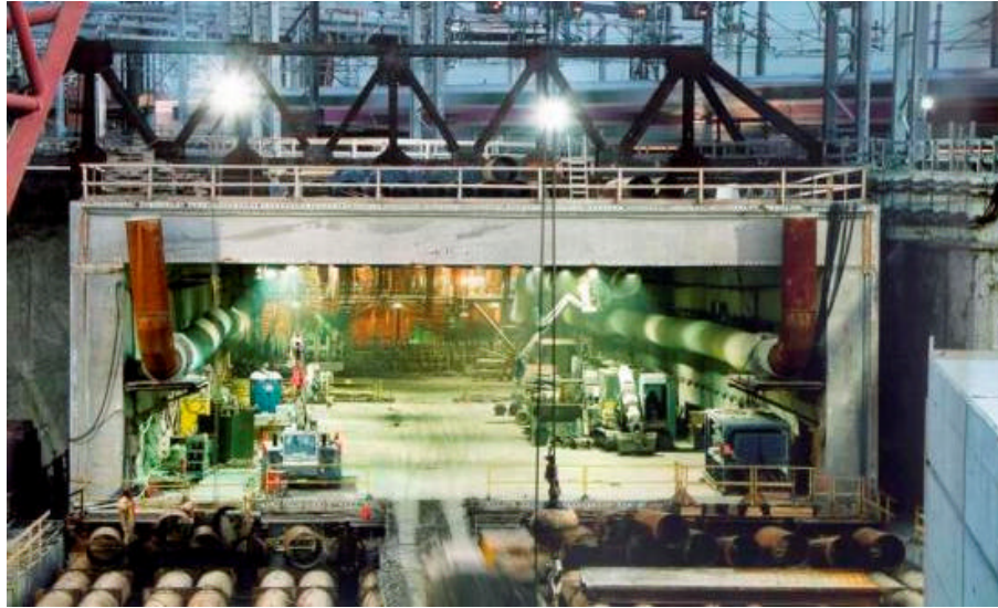
Túnel bajo la línea del tren
