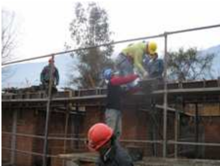
Hormigonado Cadena Coronación
