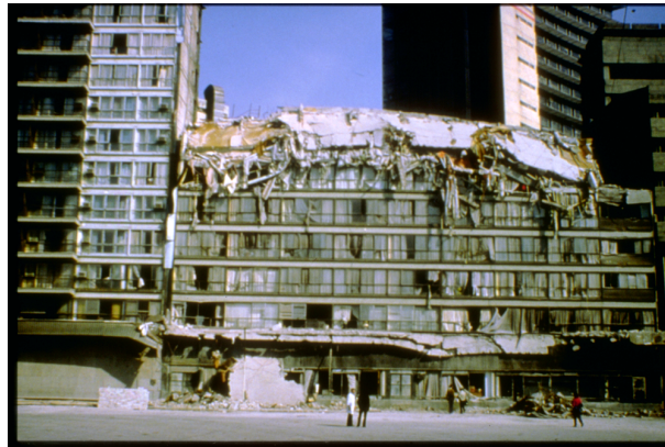
Figura 20: Derrumbe del Hotel Continental ocurrido durante el terremoto de 1985 en ciudad de México. Este edificio entró en resonancia con la frecuencia de forzaje del temblor, y sus pisos superiores colapsaron. Otros edificios contiguos, más altos o más bajos, no sufrieron los mismos daños que este hotel.
