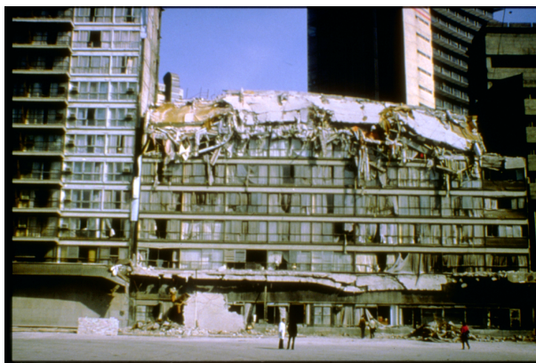
Figura 20: Derrumbe del Hotel Continental ocurrido durante el terremoto de 1985 en ciudad de México. Este edificio entró en resonancia con la frecuencia de forzamiento del temblor, y sus pisos superiores colapsaron. Otros edificios contiguos, más altos o más bajos, no sufrieron los mismos daños que este hotel.
