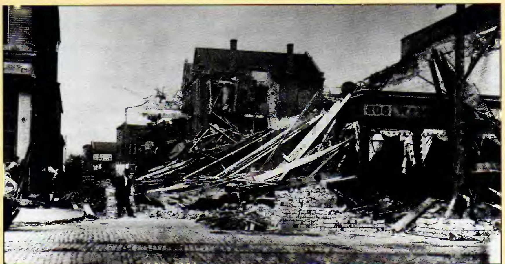
▲ Figura 11.A Daños en Charleston, Carolina del sur, causados por el terremoto que tuvo lugar el 31 de agosto de 1886. El daño osciló entre la caída de chimeneas y la ruptura de paredes hasta el hundimiento total. (Foto cortesía de U. S. Geological Survey.)
