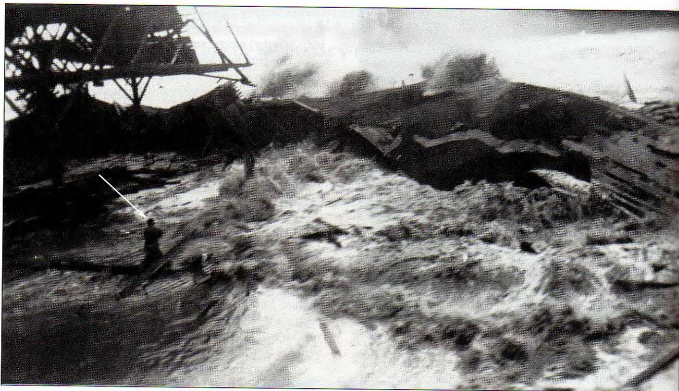
▲ Figura 11.19 Un hombre está de pie ante un muro de agua que está a punto de tragárselo en Hilo, Hawaïi, el 1 de abril de 1946. Este tsunami, que se originó en las islas Aleutianas, cerca de Alaska, todavía era lo bastante potente cuando azotó Hawaïi como para elevarse de 9 a 16 metros. El S. S. Brigham Victory , desde donde se tomó esta fotografía, consiguió sobrevivir la arremetida, pero 159 personas perdieron la vida en Hawaïi, entre ellas el hombre de la imagen. (Foto cortesía del Water Resources Center Archives, Universidad de California, Berkeley.)
