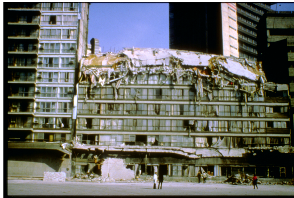
Figura 5C.2: Derrumbe del Hotel Continental ocurrido durante el terremoto de 1985 en ciudad de México. Este edificio entró en resonancia con la frecuencia de forzamiento del temblor y sus pisos superiores colapsaron. Otros edificios contiguos, más altos o más bajos, no sufrieron los mismos daños que este hotel pues tenían frecuencias naturales diferentes.
