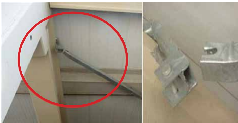
Figura 3.20. Conexión de arriostros de perfiles tubulares.
