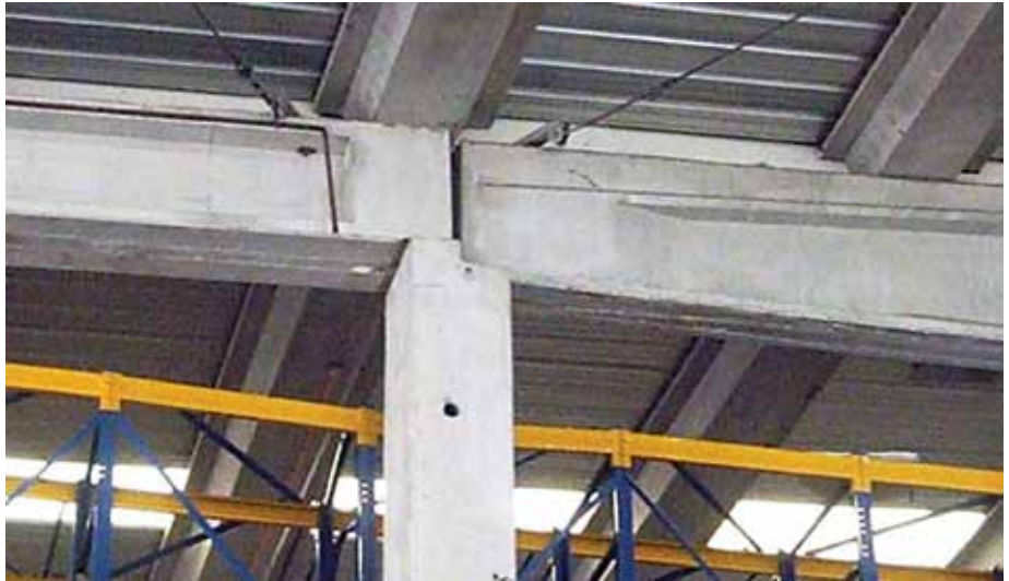
Figura 3.7. Encuentros pilar intermedio - vigas principales en distinto nivel de apoyo.
