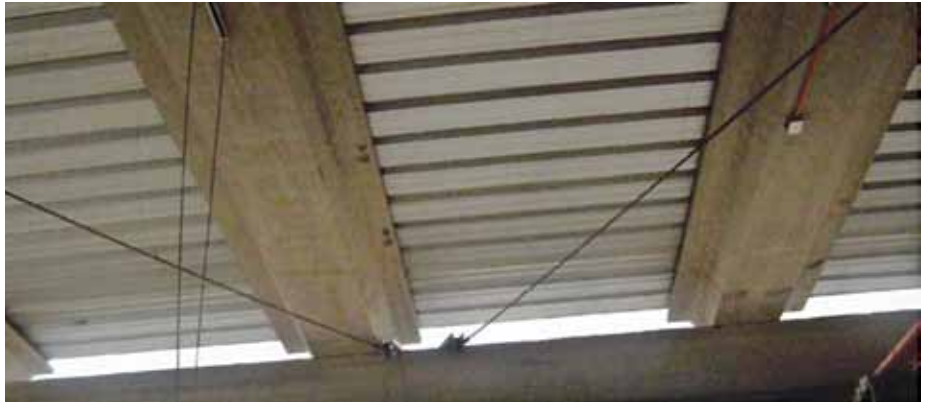
Figura 3.18. Arriostamiento de cables en X.
