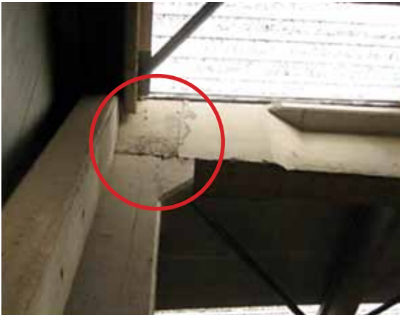
Figura 3.11. Encuentros pilar - viga, conexión continua.
