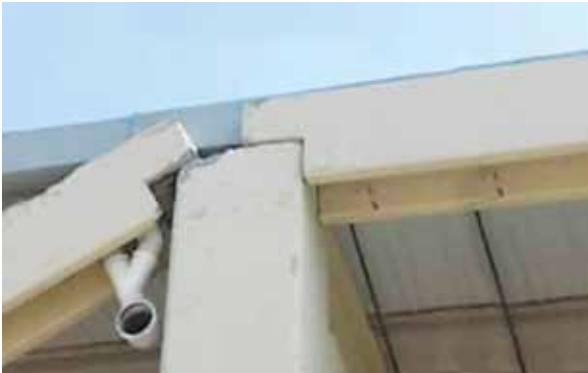
Figura 3.5. Encuentros pilar de borde - vigas secundarias.
