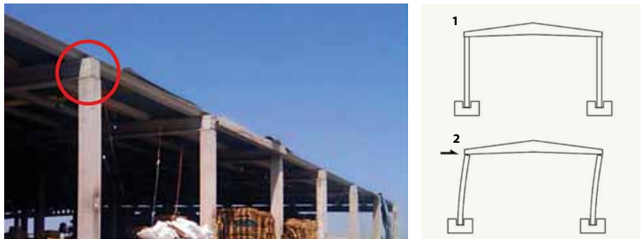
Figura 3.3. Encuentros pilar de borde - viga principal.
