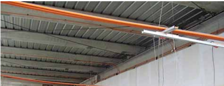
Figura 3.17. Arriostramiento de cables en X.
