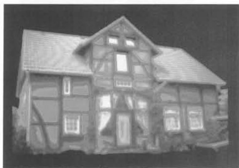
Este termograma de una casa muestra que la energía térmica está siendo irradiada al medio exterior.
