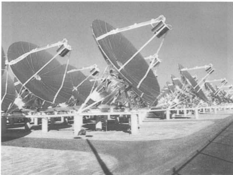
La energía solar se concentra y recoge individualmente para producir electricidad mediante estos heliostatos que se están probando en el Sandia National Laboratory (Estados Unidos).
