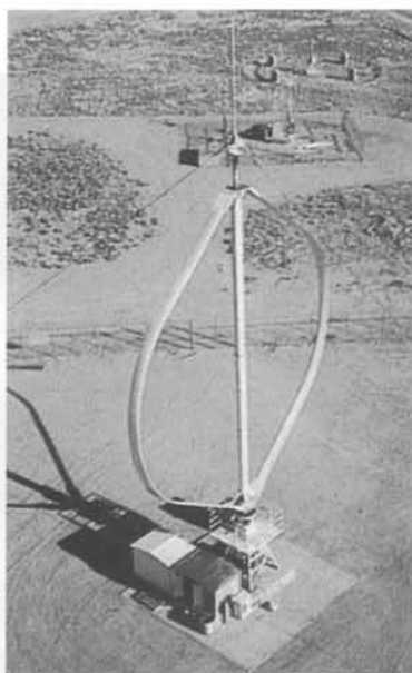
Generador eléctrico experimental accionado por el viento en el Sandia National Laboratory (Estados Unidos). El tipo de hélice propulsora está proyectado para una transferencia óptima de la energía del viento a energía mecánica.
