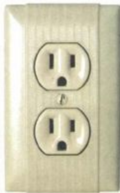
Enchufe ordinario de pared. La compañía eléctrica mantiene una diferencia de potencial de 120 V (o 220 V) entre las tomas de corriente. Cuando un calentador u otro dispositivo se conecta al enchufe, cada coulombio que pasa por el calentador disipa 120 J (o 220 J) de energía en el mismo (y los cables de conexión). El orificio redondo está conectado a tierra.
