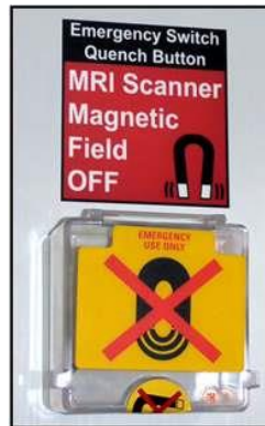
Figura 32: Botón de quench dentro de una sala de RM.
