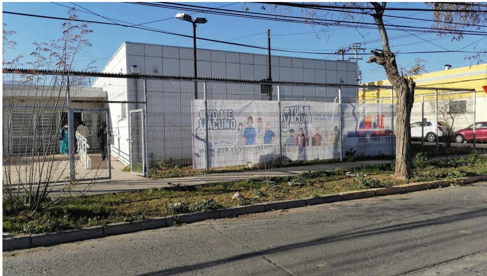
Ilustración 110 Unidad Vecinal N°52 Montreal: Montreal Esquina Pedro Mira.
