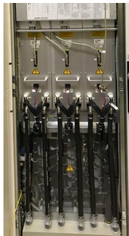
Figura 12: Amplificadores de gradientes
