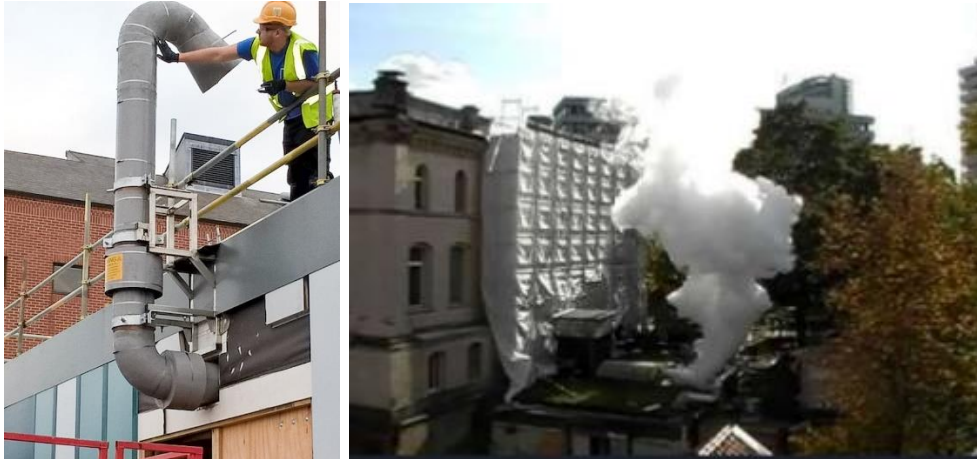
Figura 25: Izquierda, tubo de quench. Derecha, Helio en estado gaseoso siendo expulsado por el tubo de quench hacia el exterior de un resonador.
