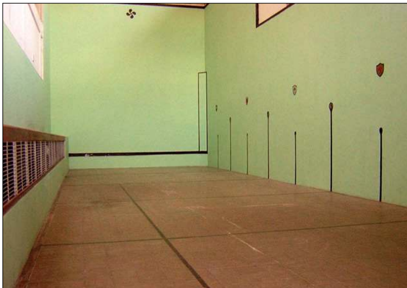
Trinkete Euzko Etxea, construido en 1957
